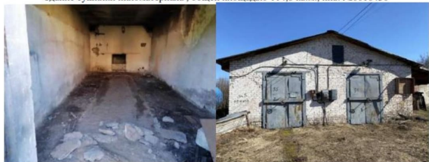
Здание сушилки пиломатериала, общей площадью 114,8 кв.м., инв. №0016430
