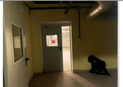
Фото.5 Нежилые помещения в здании Речного вокзала, площадь 45,5 м2
