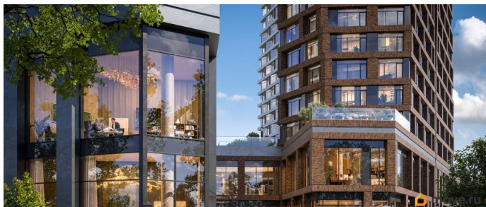
Корпус 2 полный 10-этажный
